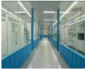
(压缩机检测中心)
