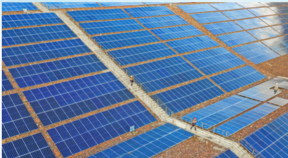
图：紫金山 3 号子坝光伏发电
