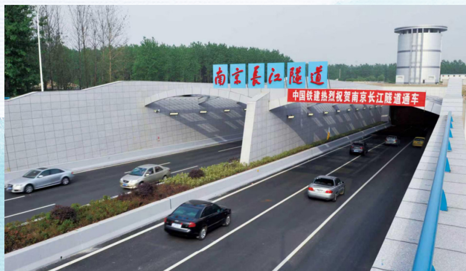
图：中国铁建建设的南京长江隧道正式通车
