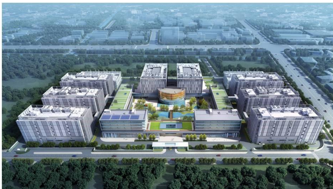
金桥数据中心
